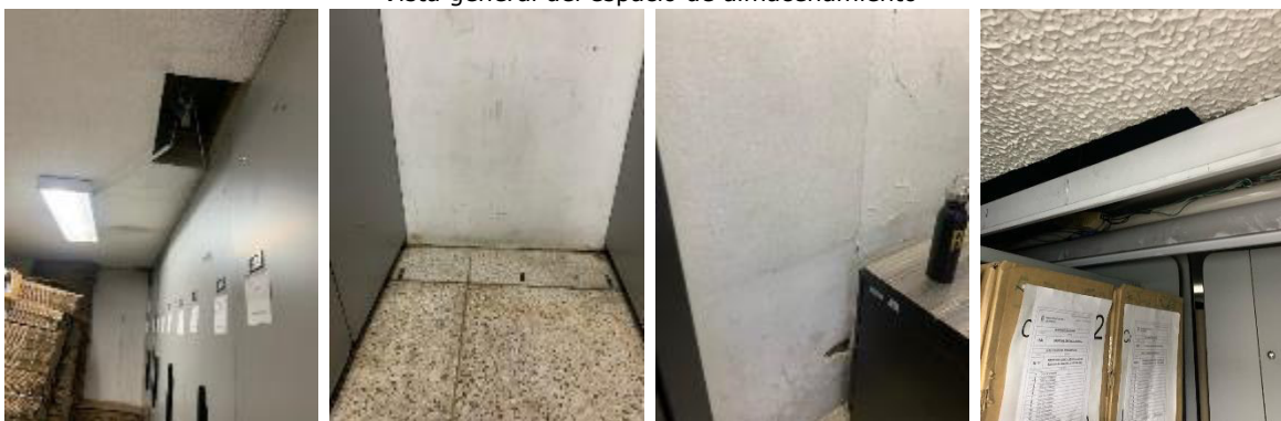
Detalle del estado de los elementos constructivos
