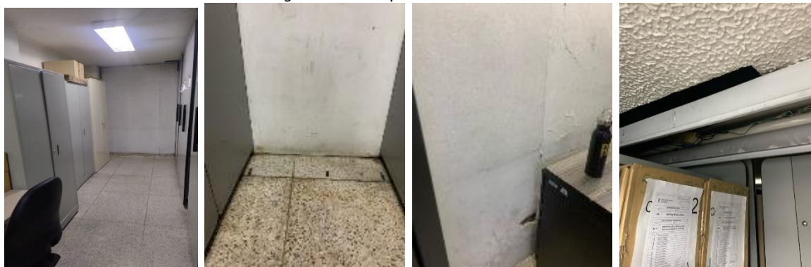
Detalle del estado de los elementos constructivos
