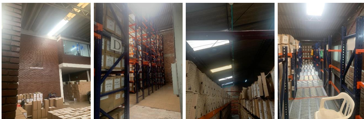
Vista general del espacio y elementos constructivos de la zona de almacenamiento
